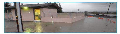
El proyecto de resistencia a las inundaciones de la estación de bombeo en Penngrove ha sido aprobado por la junta directiva de Sonoma Water. Este proyecto elevará el equipo eléctrico de la estación de bombeo fuera de la llanura de inundación de 500 años y proporcionará energía de reserva a la estación para permitir su funcionamiento durante una tormenta.
